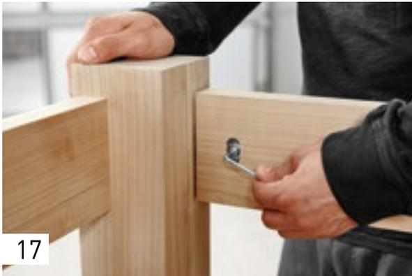
Verbindung mit einem 4-mm-Inbusschlüssel festziehen.
